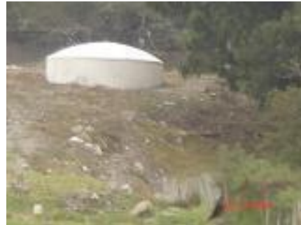
Tanque de reserva para abastecimiento a las lavadoras de vehículos
