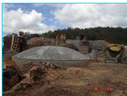
Estado de la Planta de Tratamiento (24 de febrero 2010)
