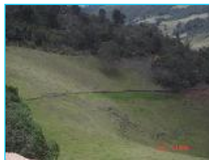
Línea de conducción
