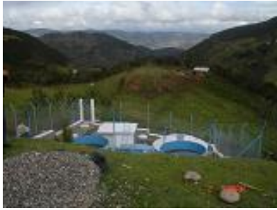
Vista superior de Planta de Tratamiento
