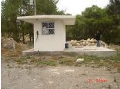
Caseta de control de sistema de bombeo
