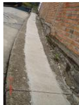
Localización de nueva matriz al interior de urbanización del CICA
