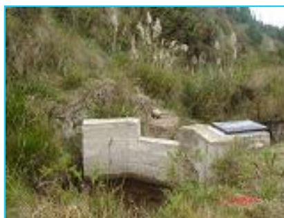
Estructura construida en la captación Ingahuasi
