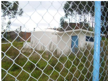
Estación de bombeo
