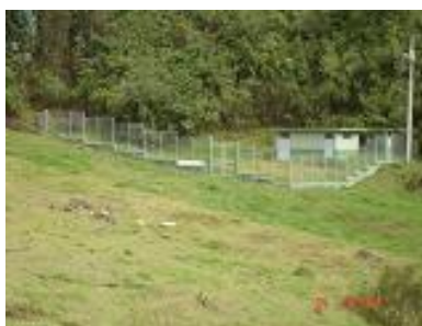
Vista lateral de la Planta de Tratamiento
