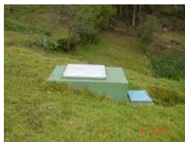
Tanque rompe presión
