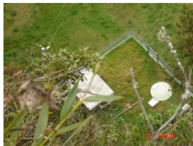
Vista superior de la Planta de Tratamiento
