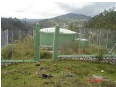
Tanque de reserva del sistema
