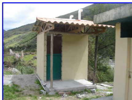
FOTO Nº 10.- Construcción de sanitario ecológico en la Escuela José Gorelik
