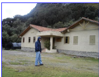
Estado de las instalaciones de Illincocha
