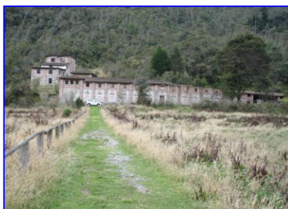
Estructura a ser readecuada en Llaviucu
