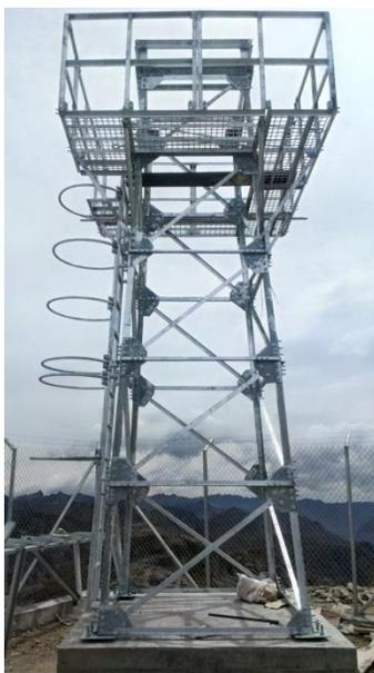
**Foto 4.** Torreo auto soportada de acero galvanizado para colocación del Radar CAXX
