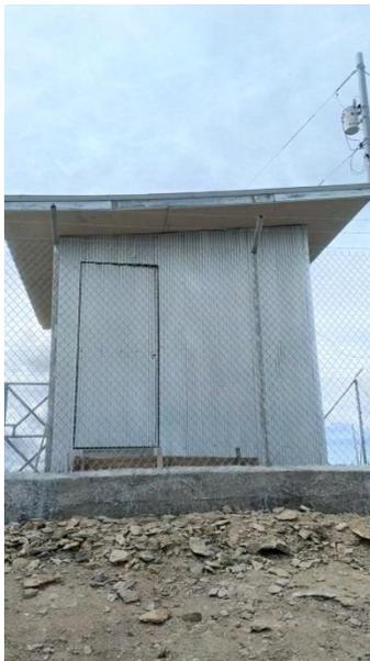
**Foto 3.** Caseta de cuadrada de 3 x 3 metros para colocación de equipos de radar respaldo eléctrico
